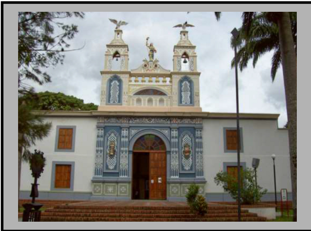
Fachada actual del antiguo Hospital Vargas de San Cristóbal
